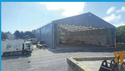
Bâtiment pour le transfert provisoire
