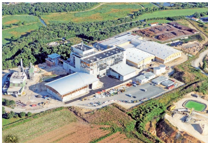
Vue aérienne du chantier - juillet 2017
